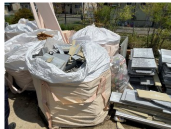
▲廃棄物保管状況
