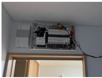
▲床置きエアコン消費電力
