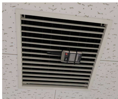
▲ 換気口の温湿度計測
