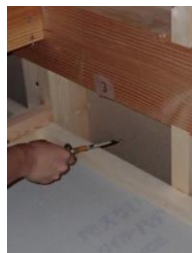
▲小屋裏から壁体内風向の計測
