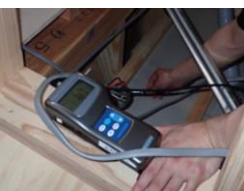
◀ 小屋裏から壁体内風速の計測
