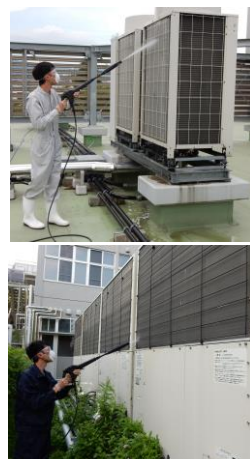
図 GHP・EHPフィン洗浄
