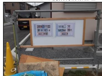
▲建設現場での分別表の掲示
