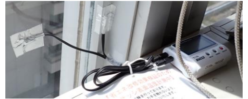
写真 窓, サッシ表面温度
