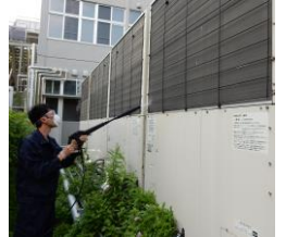
図 GHP・EHPフィン洗浄
