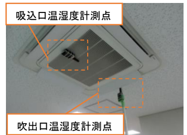
図 エアコンの吹出吸込口計測方法
