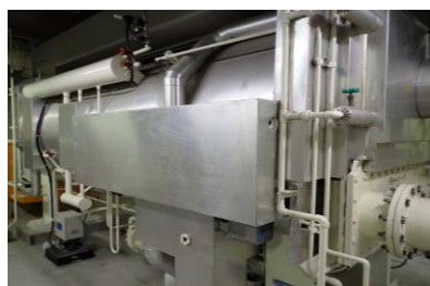
直焚吸収式冷温水機
