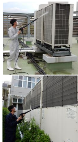
図 GHP・EHPフィン洗浄
