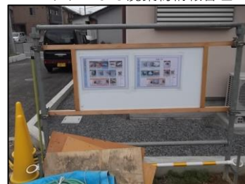
▲建設現場で廃棄物の分別表を掲示
