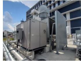
吸収式冷温水発生機 (RH-1)
