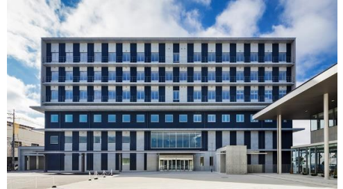
対象施設外観 石本建築事務所HP, http://www.ishimoto.co.jp/
