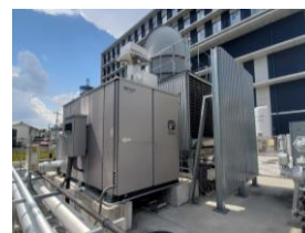
吸収式冷温水発生機 (RH-1)
