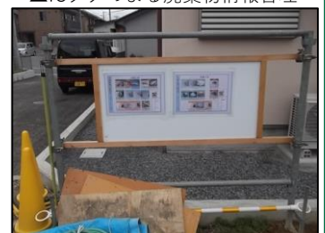
▲建設現場で廃棄物の分別表を掲示
