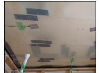
▲実験棟天井面のPCM
