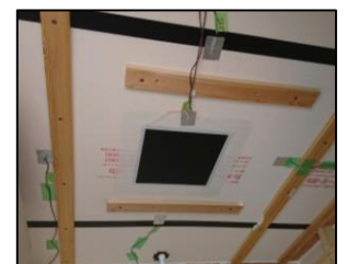
▲実験棟天井面の熱流計測
